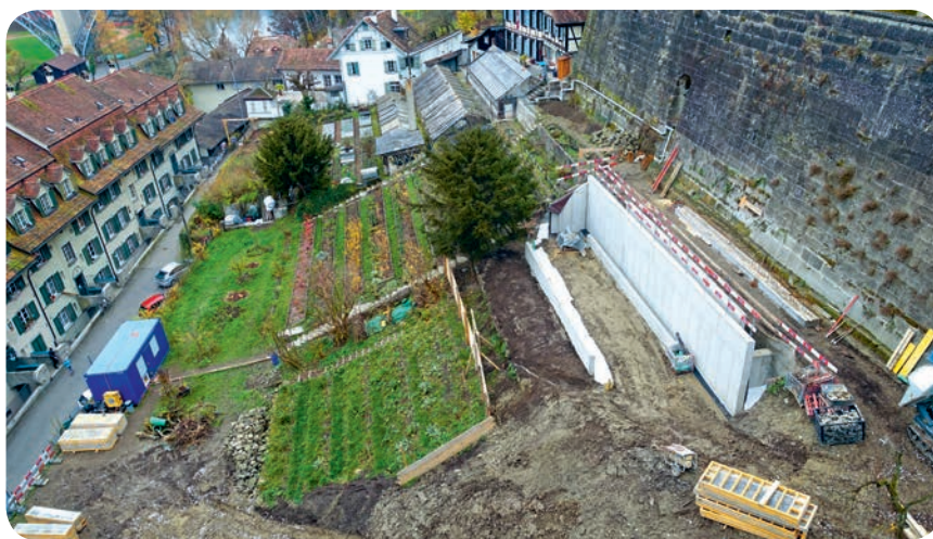
Sicht von der Münsterplattform auf die Baustelle im Stiftsgarten, Foto Angela Losert
